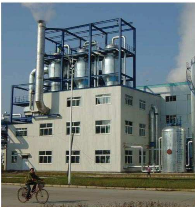
Рис. 7. 5-корпусная установка с аппаратами с падающей пленкой и с принудительной циркуляцией, нагревается отработанным паром из сушилки, сгущает барду от 6,6 % до 35 % сухих веществ с производительностью 140 т/час, вариант С.
