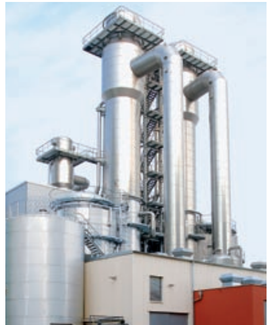
Konzentrierung von Kartoffelfruchtwasser Zwei Vorverdampfer mit mechanischer Brüdenverdichtung und ein Endverdampfer mit thermischer Brüdenverdichtung Verdampfleistung: gesamt 152.000 kg/h
