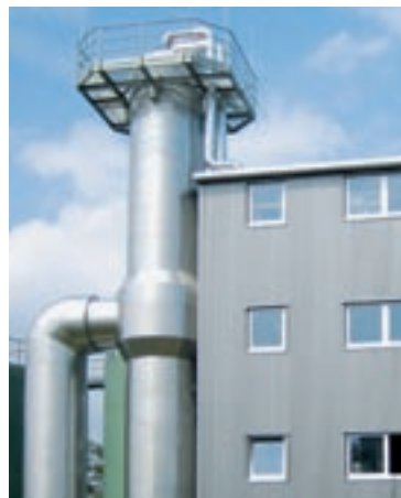
Fallstrom-Zwangsumlauf-Eindampfanlage mit mechanischer Brüdenverdichtung Verdampfleistung: 9.000 kg/h
