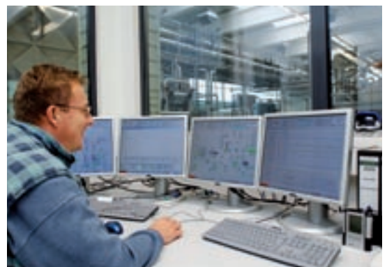
Prozessleitwarte einer mehrstufigen vollautomatischen Eindampfanlage
