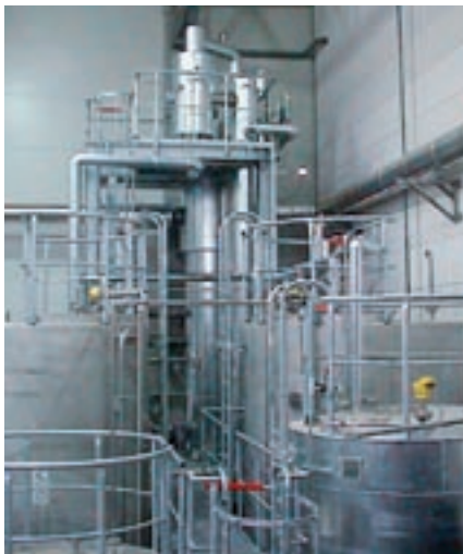
Zweistufige Eindampfanlage für Holzdämpfungsabwasser, Verdampfleistung: 5.000 kg/h
