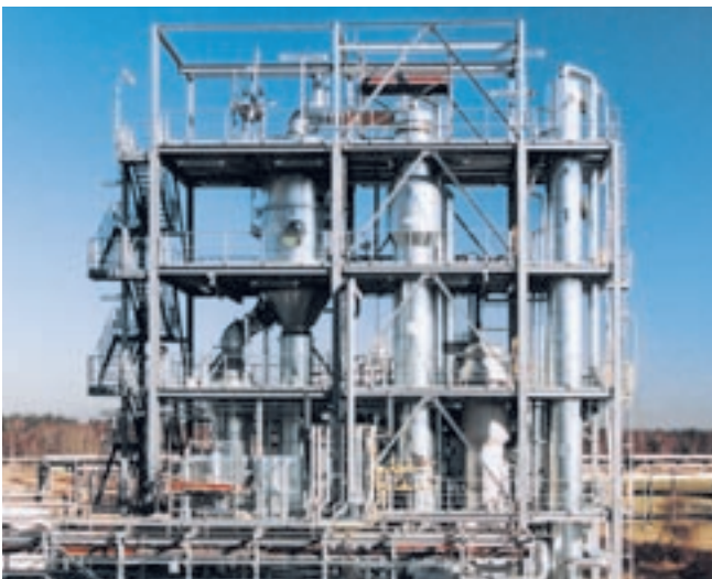
Zweistufige Fallstrom-Zwangsumlauf-Eindampfanlage in Gegenstromschaltung mit nachgeschalteter destillativer Reinigung des Brüdenkondensates Verdampfleistung: 9.000 kg/h bei einer Konzentrierung auf 65 % TS (Trockensubstanz)
