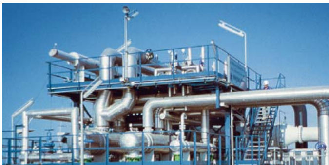
Vakuum-Einheit für eine MSF-Meerwasserentsalzung
