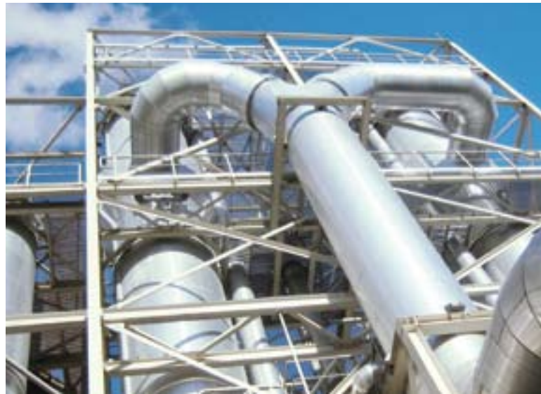
EINDAMPFANLAGE zur Aufkonzentrierung von Abwasser aus der Weizenstärkeherstellung, beheizt mit einem mechanischen Brüdenverdichter. Verdampfleistung: 30.000 kg/h
