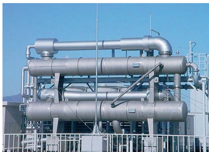
Рис. 5. 2-ступенчатая пароэжекторная холодильная установка компактного типа, охлаждает 44 м 3 /час воды от 30 до 10 °С.
