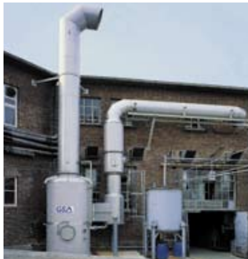
Однокорпусной плавно регулируемый скруббер Вентури U-типа для удаления пыли: расход всасываемой среды: 30 000 м 3 /ч потери давления: 20 мбар
