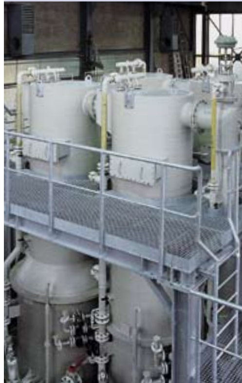
Струйный скруббер II типа для кислых и щелочных отработанных газов
