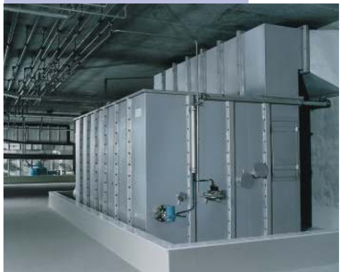
Lavador de gases para la separación de partículas de pintura suministrado en una planta industrial para pintar aviones. material: acero inoxidable 1.4571
