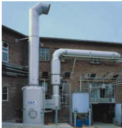
Lavador tipo venturi modelo U de una etapa regulable en continuo, para el tratamiento de gases con partículas de polvo. Caudal de aspiración 30.000 \text{ m}^3/\text{h} , pérdidas de carga de 20 mbar.
