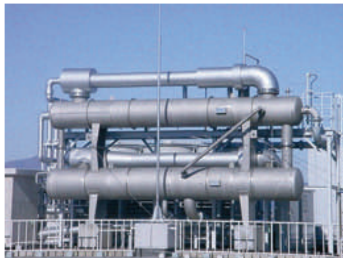
图5：紧凑设计的2级蒸汽喷射制冷装置，可将44m 3 /hr水从30℃冷却至10℃
